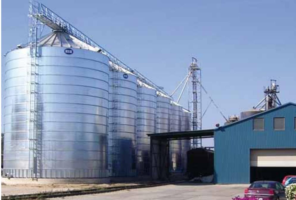
Widok magazynu z rzędowym układem silosów.
