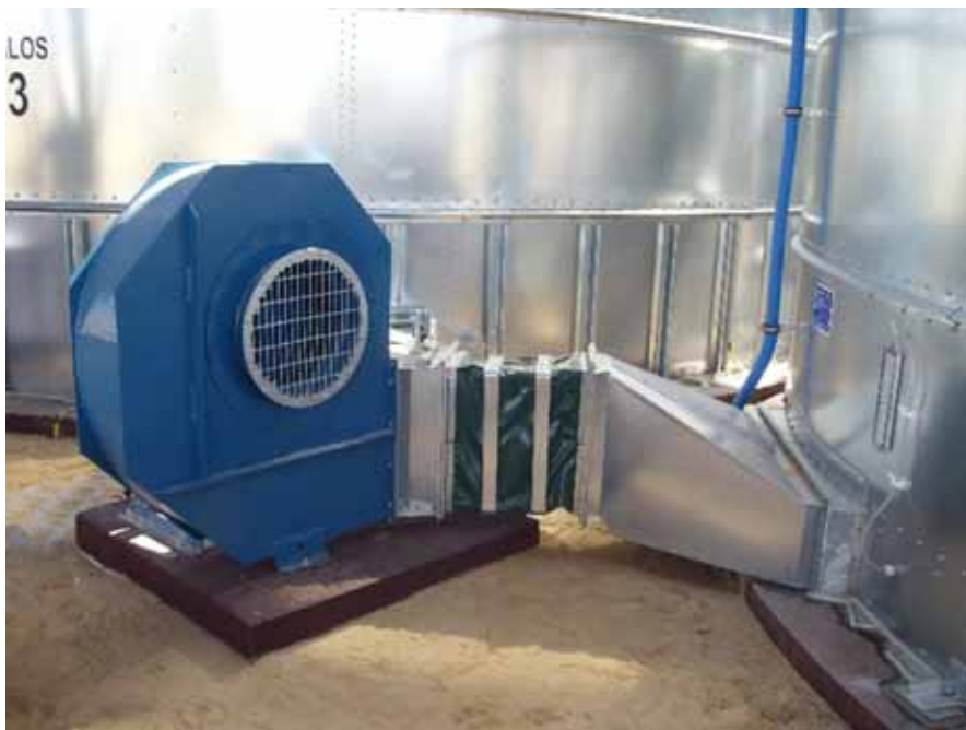
Wentylator przewietrzający
